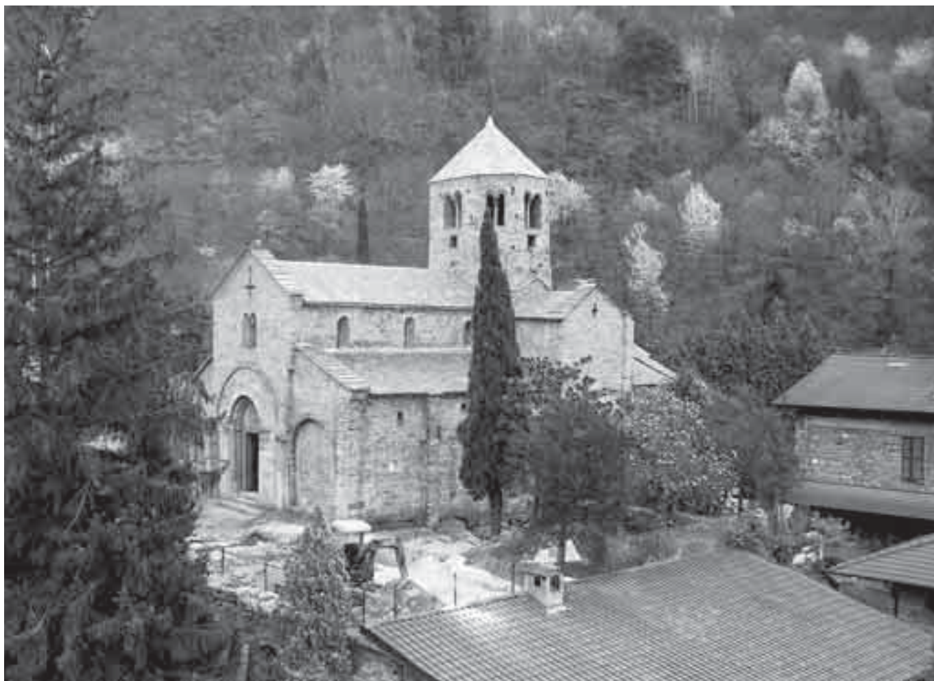
81 - Capo di Ponte. Chiesa di S. Salvatore.
