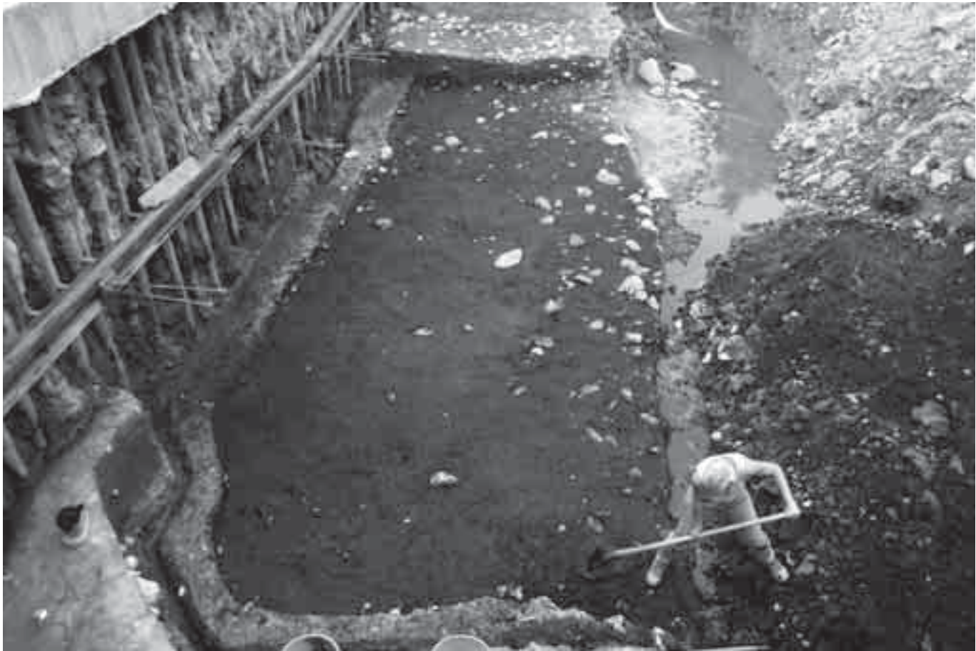
242 - Teglio, via Roma, parcheggio hotel Meden. Livello torboso, dovuto ad interrimento naturale, in fase di scavo.
