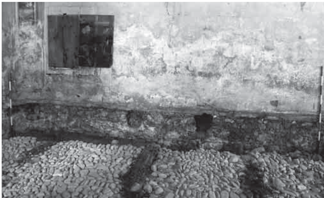
238 - Livigno, Oratorio del Santo Rosario. I fori nel muro perimetrale servivano all'alloggiamento delle travi su cui poggiava l'assito ligneo (XVII secolo).
