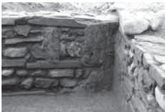
253 - Arsago Seprio, via Cattaneo. Particolare dei residui di malta.
