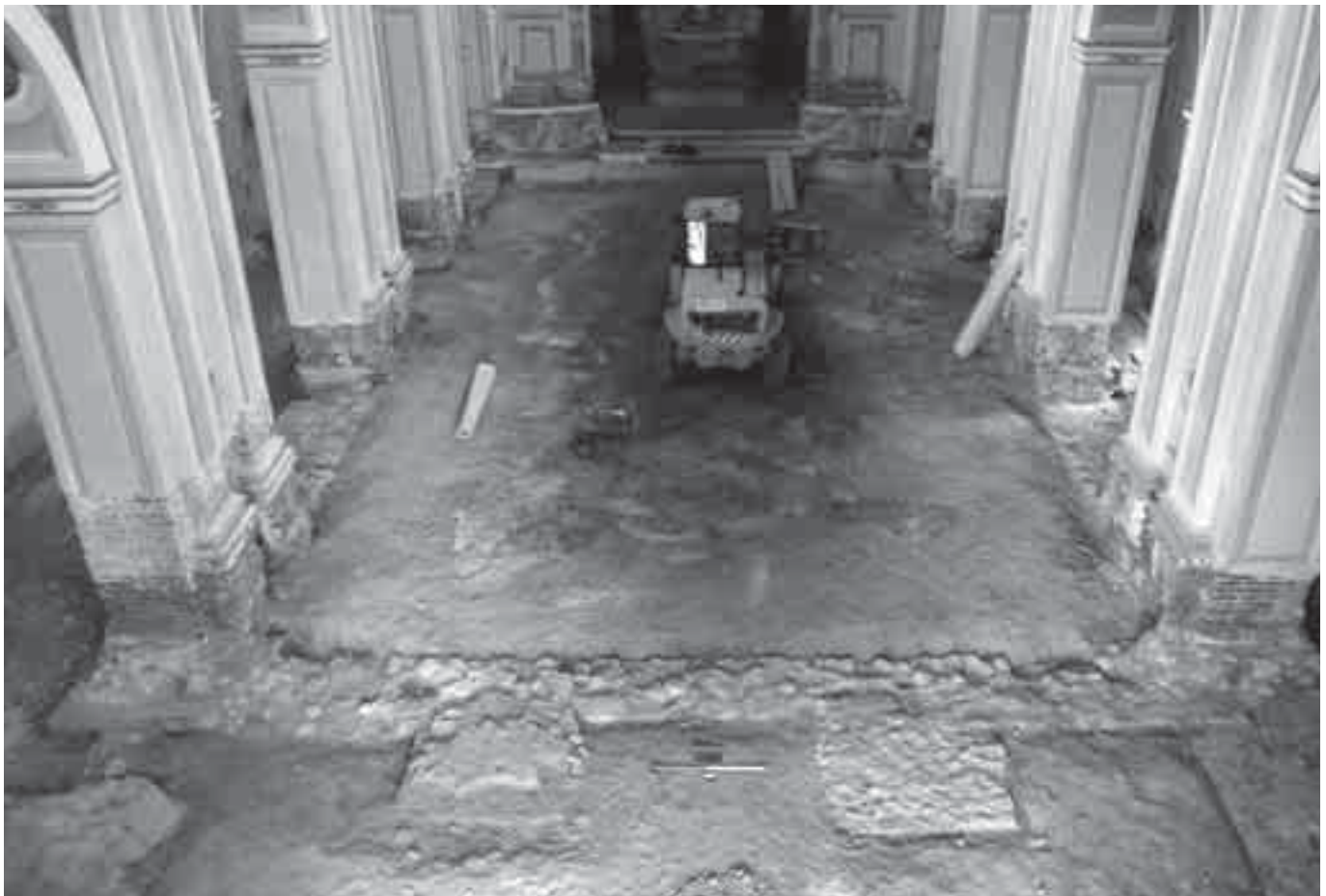
272 - Ferno, chiesa di S. Antonio. Panoramica dello scavo.
