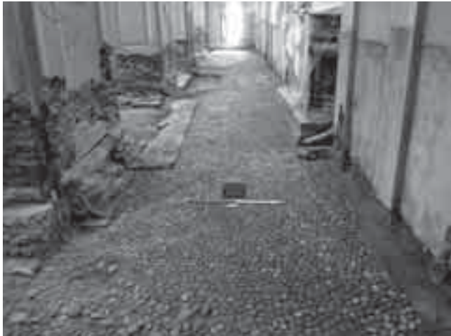
273 - Ferno, chiesa di S. Antonio. Strada acciottolata nella navata sinistra US 132.
