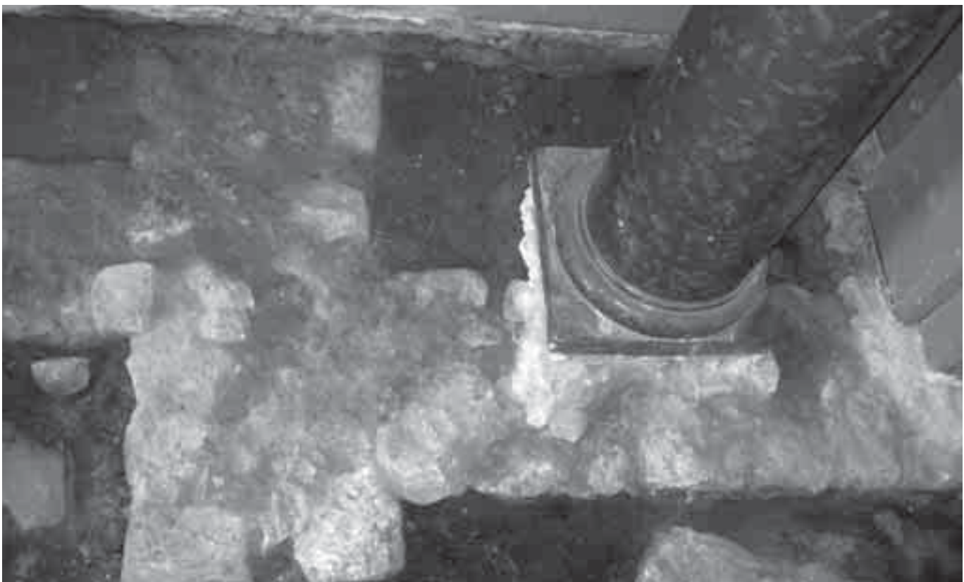
270 - Cugliate Fabiasco, chiesa di San Giulio Prete. Particolare del contrafforte della chiesa di fase 2.
