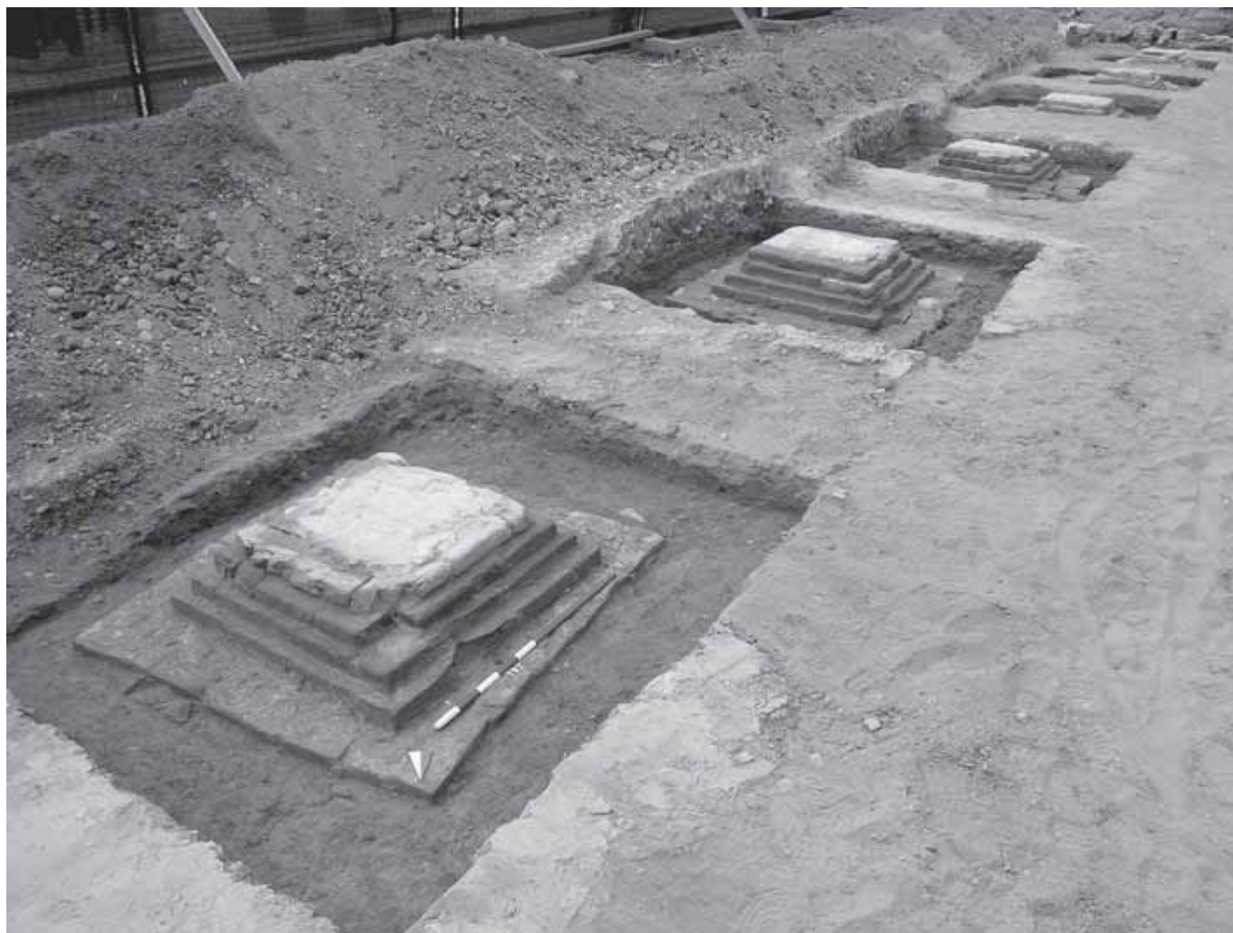
114 - San Benedetto Po, piazza T. Folengo. "Granaio", basi di pilastri.
